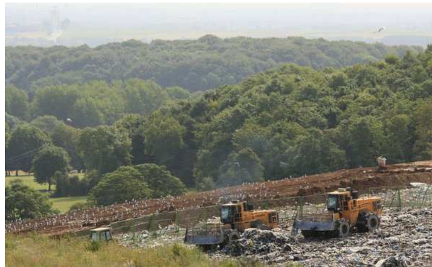
Stockage des déchets dans une alvéole étanche
