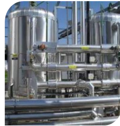
Filtration sur médias (Charbon actif, dioxyde de manganèse, alumine...)
