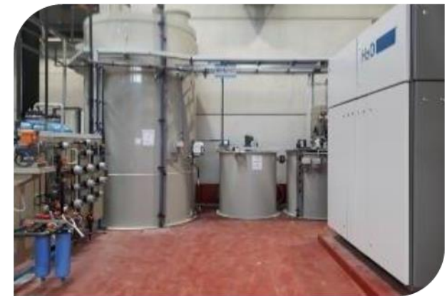
Recyclage sur résines échangeuses d'ions et évaporateur sous vide
