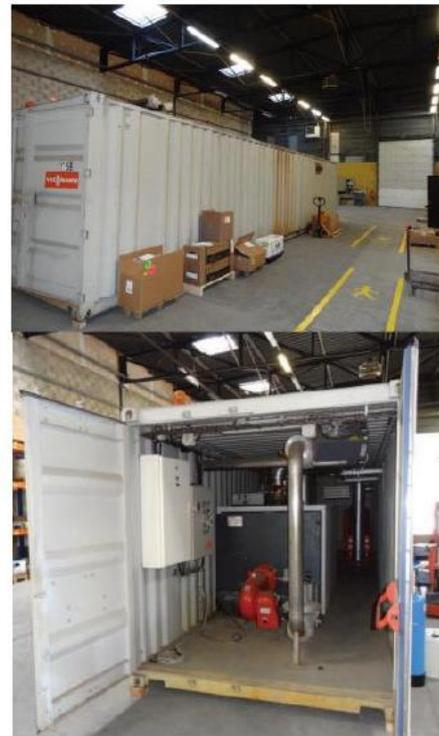
Figure 6 – Chaudière montée dans un container
