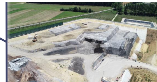
Casier de stockage des déchets
