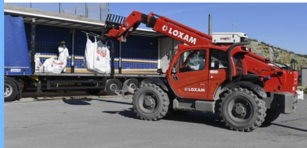
Issus de la décontamination des constructions et des différentes voies du réseau routier
