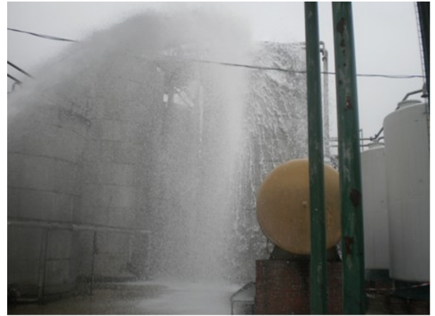
Mise en œuvre d'un canon à mousse
