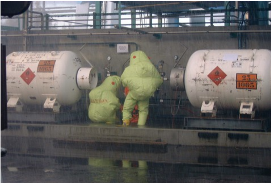
Mise en place d'un collier d'obturation de fuite
