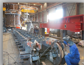
Chaudronnerie Structure métallique
