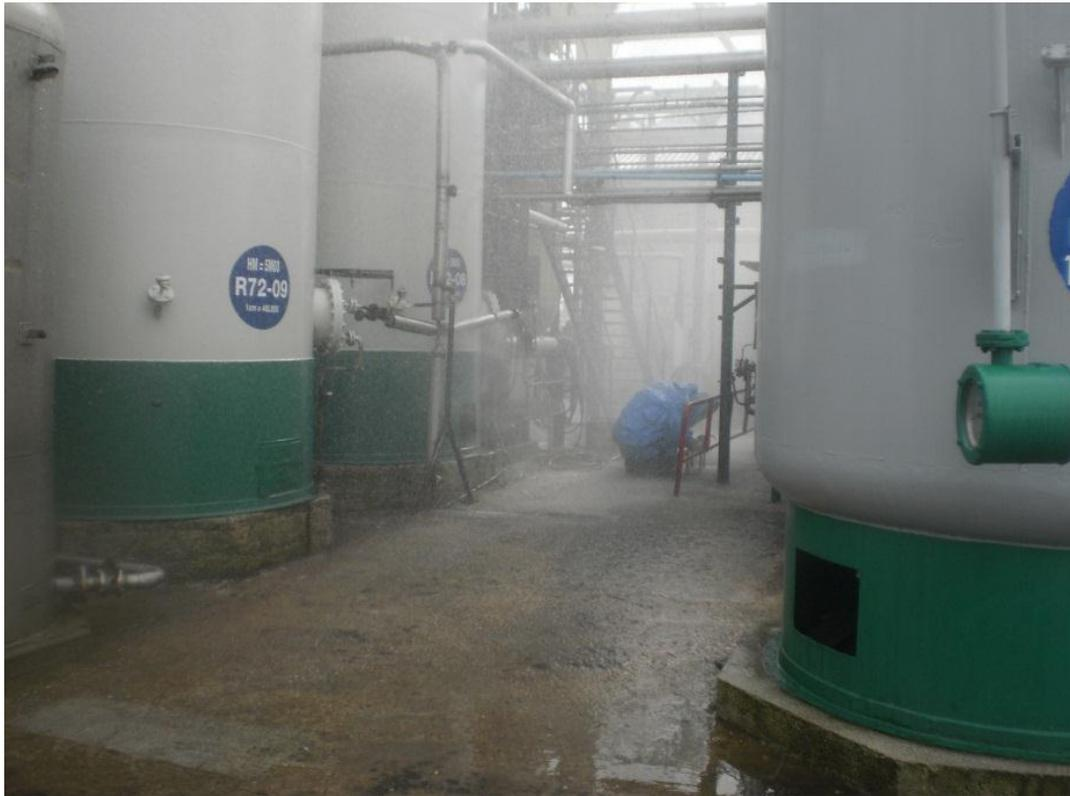
*Remplacement d'un joint sur bride par un binôme en tenue scaphandre*
