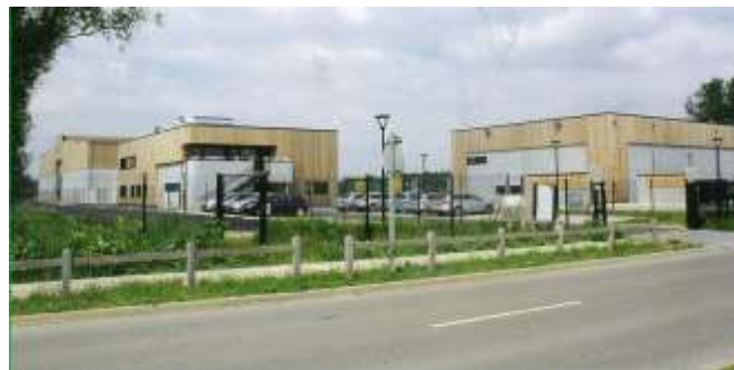
vue du site à l'achèvement des travaux
